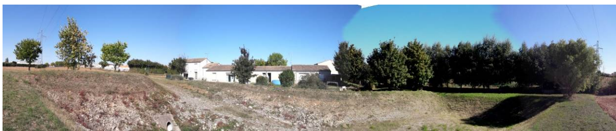
Vue du bassin existant.
